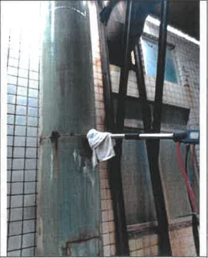
炉窑废气排放口 2#
