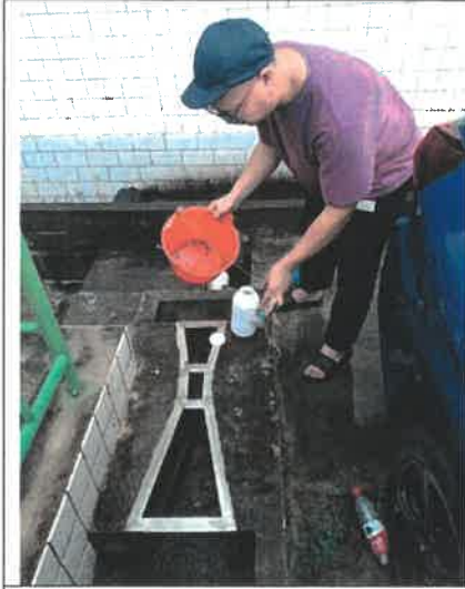
废水总排放口
