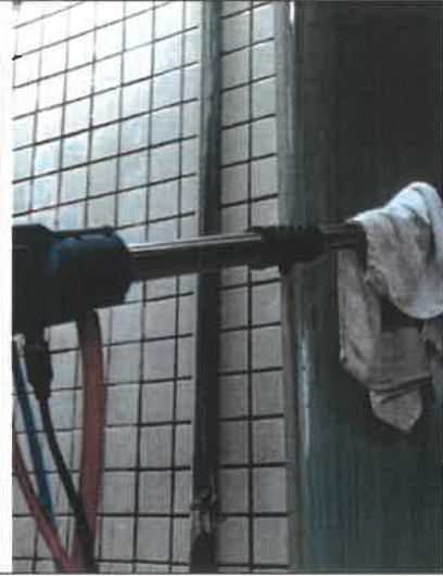
炉窑废气排放口 1#
